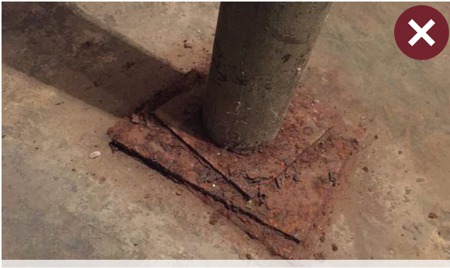
الشكل ٢,٣٩: صدأ قاعدة عمود هيكل المظلة
