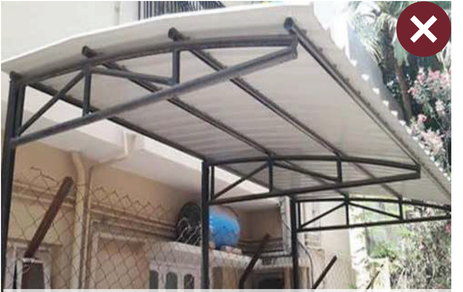
الشكل ٢،٣٣: تغطية المظلات بالمواد المحظورة
