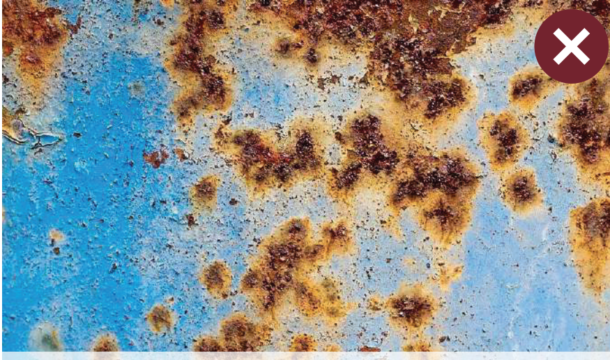
الشكل ٢,٣٨: تقشر وصدأ التشطيبات المعدنية المطلية
